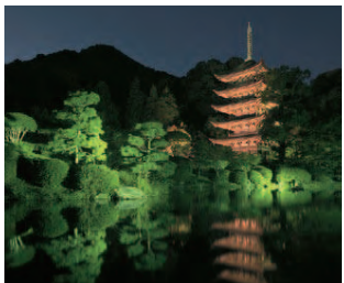
【瑠璃光寺五重塔】年間を通して、日没～22時まで、ライトアップされる
